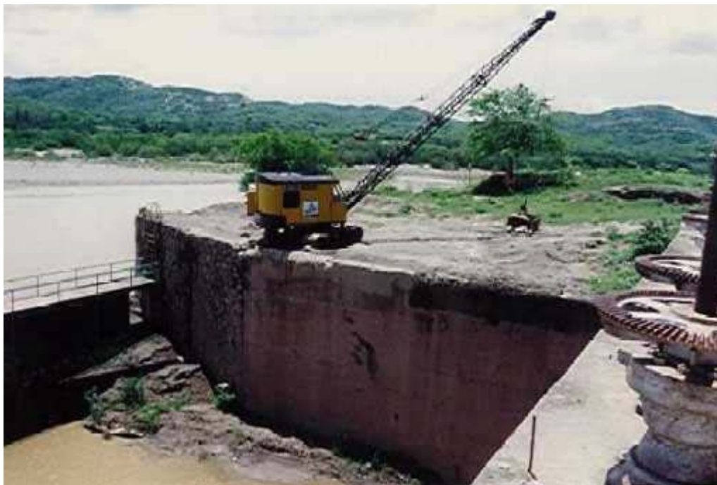
Fotografía 3.3a Obra de toma directa en río
