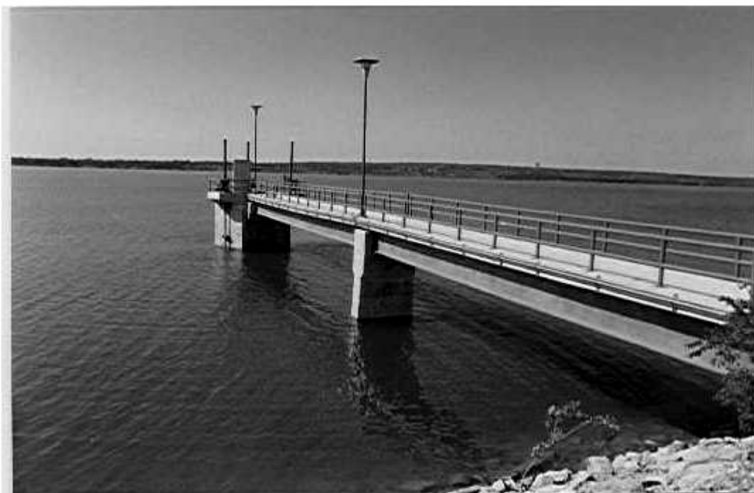
Fotografía 3.52 Obra de toma para agua potable
