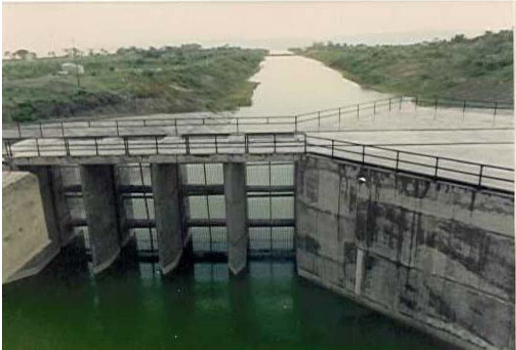
Fotografía 3.2 Obra de toma directa con canal de llamada
